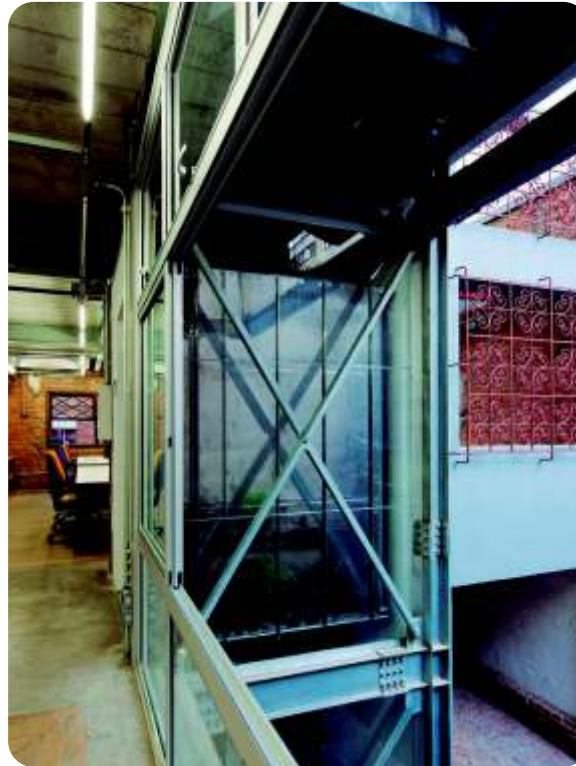
Casa Marília - SP Projeto Arquitetônico: SuperLimão Studio Projeto Estrutural: SuperLimão Studio e Ricardo Zulkes Revista Arquitetura & Aço – Edição 54
