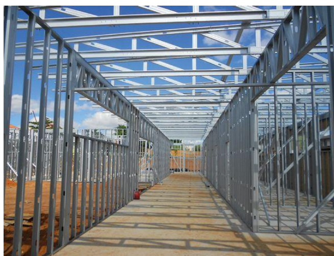
Os perfis estruturais podem ser cortados ou furados, recompondo-se a proteção contra corrosão. O espaçamento usualmente adotado entre os montantes é de 40 cm, variando conforme projeto estrutural
