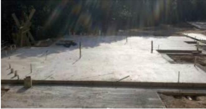
Figura 8: Execução do elemento de fundação – diferença de cota entre calçada e piso interno
