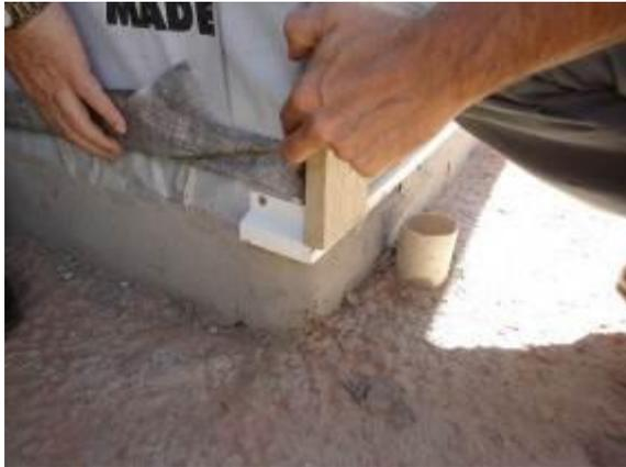
Figura 10: Pingadeira inserida na base das paredes antes da fixação das chapas *SmartSide Panel*
