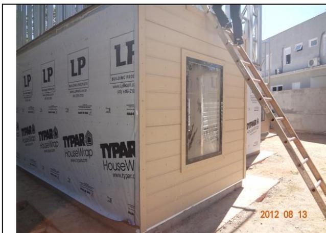
Figura 1: Vista de unidade habitacional com fechamento da face externa das paredes em chapas de OSB tipo *SmartSide Panel* posicionado na horizontal
