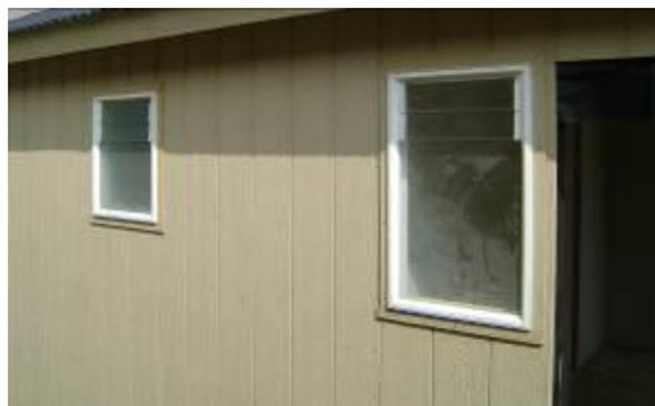
Figura 2: Vista de unidade habitacional com fechamento da face externa das paredes em chapas de OSB tipo *SmartSide Panel* posicionado na vertical
