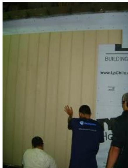
Figura 11: Posicionamento e fixação do *SmartSide* sobre barreira impermeável
