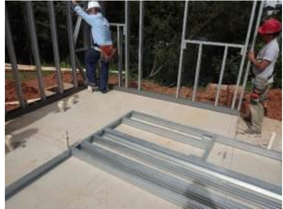
Figura 9: Posicionamento dos quadros estruturais das paredes nos locais definitivos
