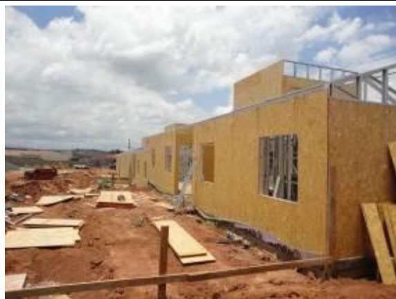
Figura 10: Fixação das chapas de OSB aos quadros estruturais
