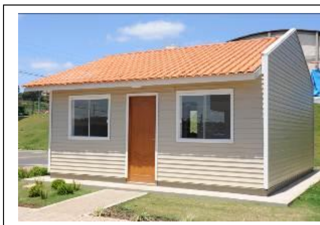
Figura 1: Vista de unidade habitacional com acabamento externo em siding vinílico
