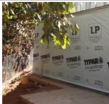
Figura 11: Fixação da barreira impermeável sobre o OSB estrutural
