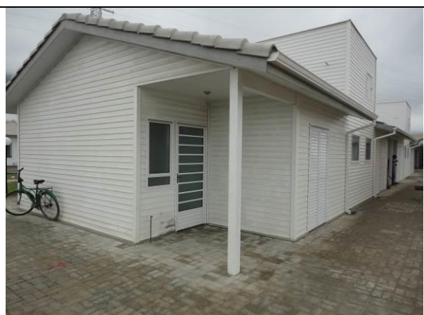
Figura 2: Vista de unidade habitacional com acabamento externo em siding vinílico
