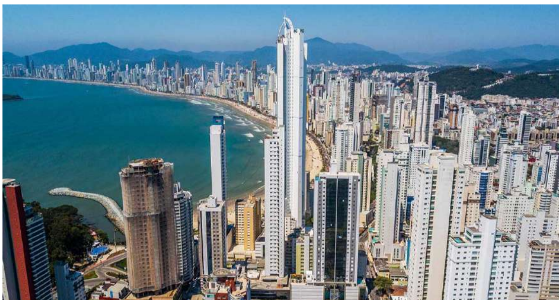
Figura 1 - Edifícios altos em Balneário Camboriú (Santa Catarina/SC, Brasil).
