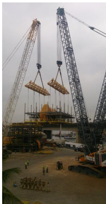
Fig. 1 - Içamento de um módulo completo Fig. 2 - Içamento de uma subestrutura
