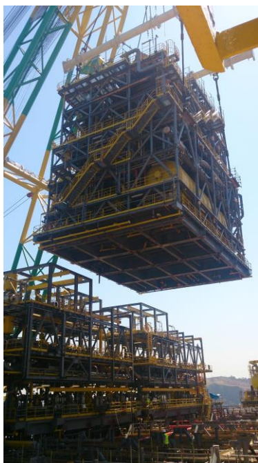
Fig. 1 - Içamento de um módulo completo Fig. 2 - Içamento de uma subestrutura
