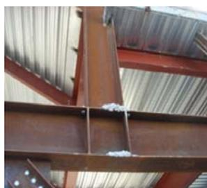
(b) Viga de transição apoiando pilar (extraído de Fakury *et al.*, 2016)
