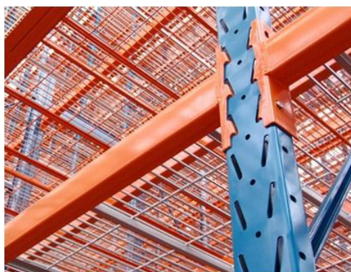
Figura 3 - Encaixe das vigas e pilares (Águia, 2013)
