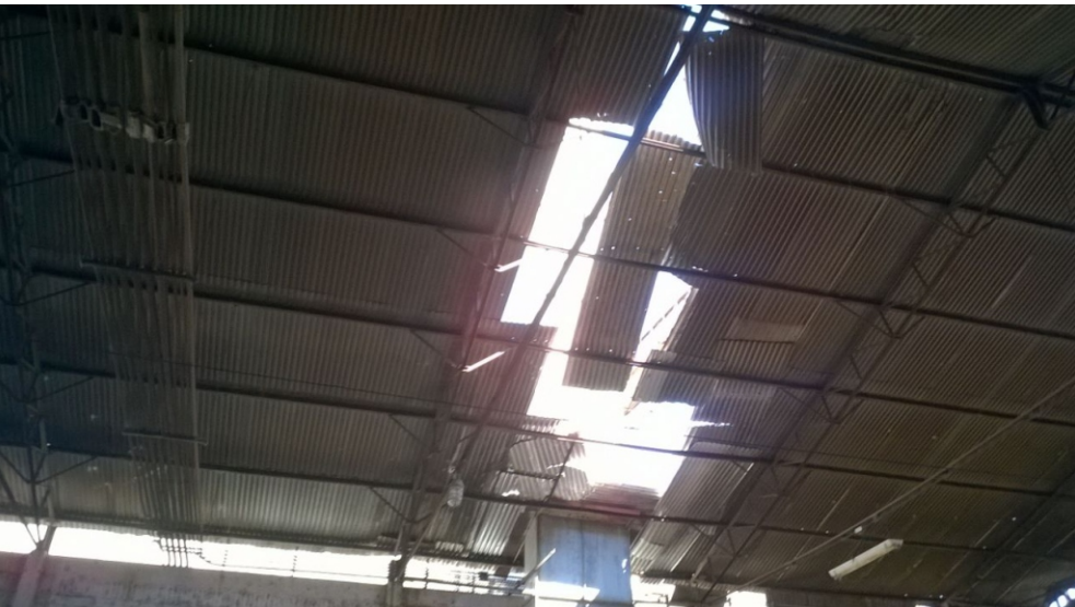
02 Telhas e estruturas metálicas deterioradas Fonte: Acervo da Equipe
