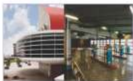
Edifício Garagem e Praça do Aeroporto Internacional de Congonhas
