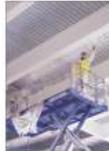
Trabalhador em uma plataforma elevatória trabalhando em uma estrutura de aço.
