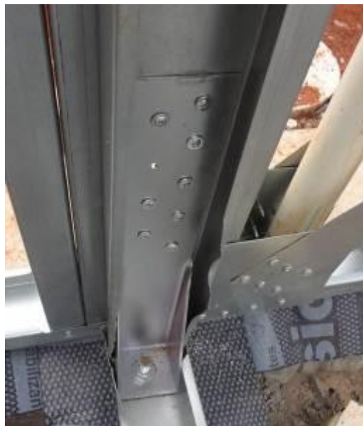
Figura 4 - Suporte de ancoragem posicionado no interior dos quadros estruturais
