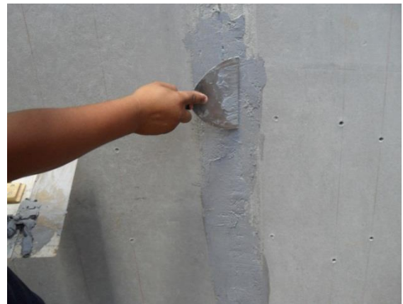
Figura 20: Preenchimento das juntas com massa.
