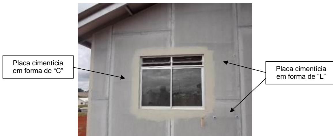
Figura 5 - Paginação das placas cimentícias e aberturas
