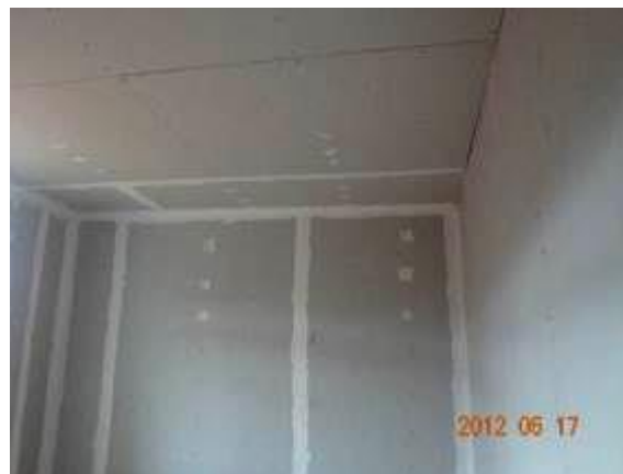
Figura 22: Acabamento das juntas entre chapas de gesso para drywall
