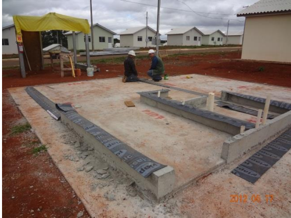
Figura 13: Radier com o embasamento nas bases das paredes que delimitam cozinha, banheiro e área de serviço, com manta asfáltica posicionada na região das paredes
