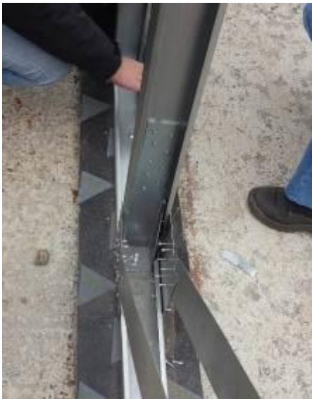
Figura 15: Fixação dos quadros estruturais à fundação
