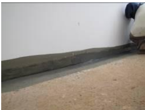
Figura 23: Impermeabilização da base da parede da cozinha
