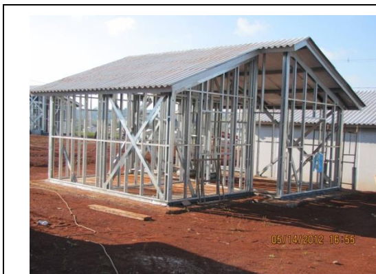
Figura 1 – Montagem dos quadros estruturais das paredes e cobertura constituídos de perfis leves de aço de uma unidade habitacional térrea
