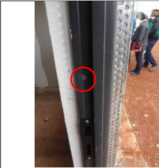
Figura 17: Parafuso de fixação das esquadrias
