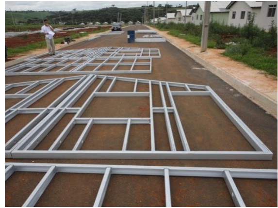
Figura 14: Montagem dos quadros estruturais fora do seu local definitivo
